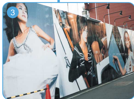
街並の環境に調和した 工事仮囲い (東京都青山通り)
