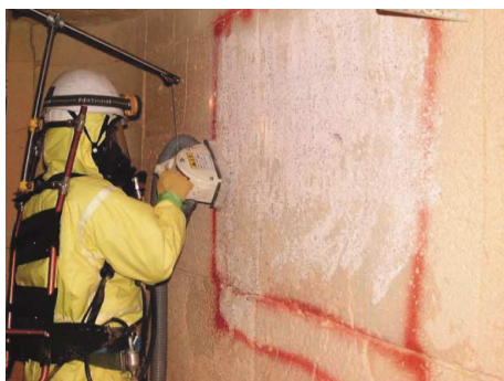
炉内除染状況(乾式除去)
