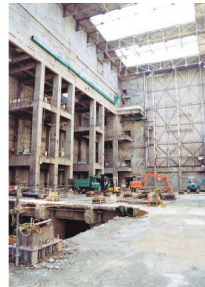
ごみ受けエリア解体(福岡市)
