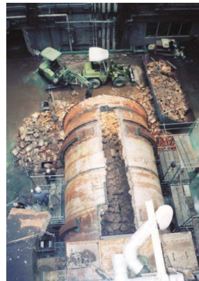
清掃工場の煙道解体(東京都)
