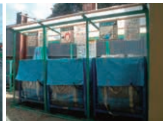
分別保管ヤード
