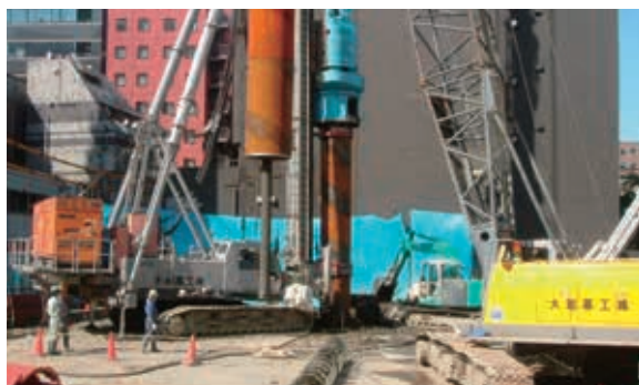
施工状況(東京都)
