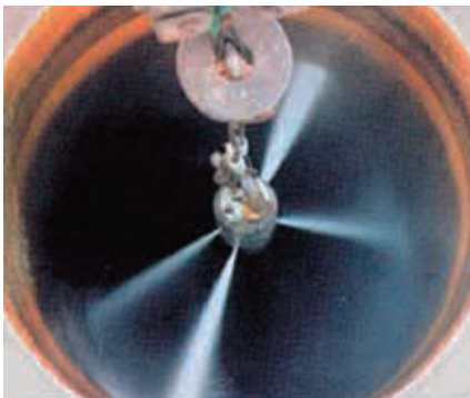
湿式による煙突の洗浄
