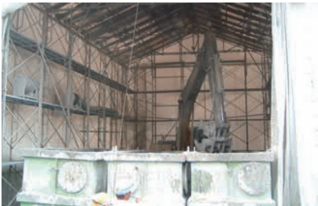
バックホーによる攪拌状況
