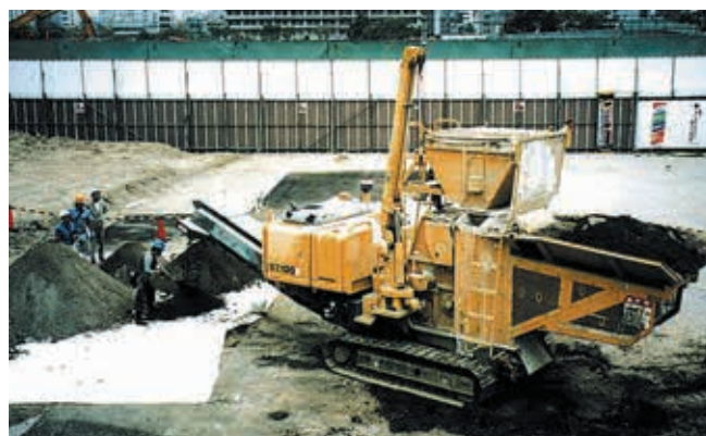
重金属汚染土壌の固化・不溶化処理
