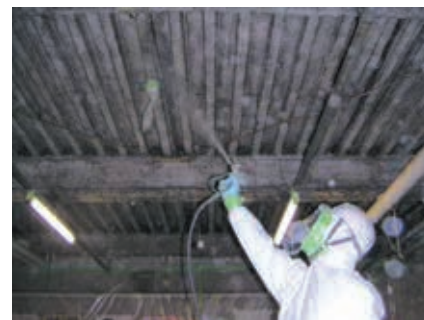
アスベスト除去(飛散防止)作業
