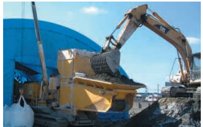
自走式攪拌機による攪拌状況
