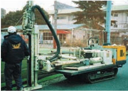
ボーリング調査
