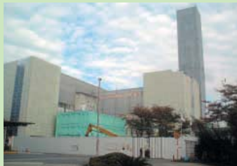
施設の養生状況
