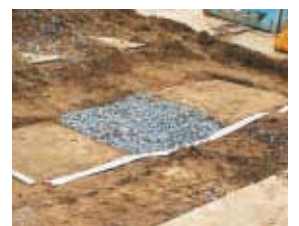
埋め戻しの状況
