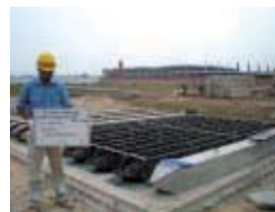
作業所での サイトPC杭の製作
