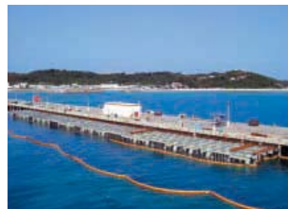
濁水拡散防止対策状況
