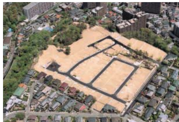
造成工事全景（企画・事業主：積水ハウス）
