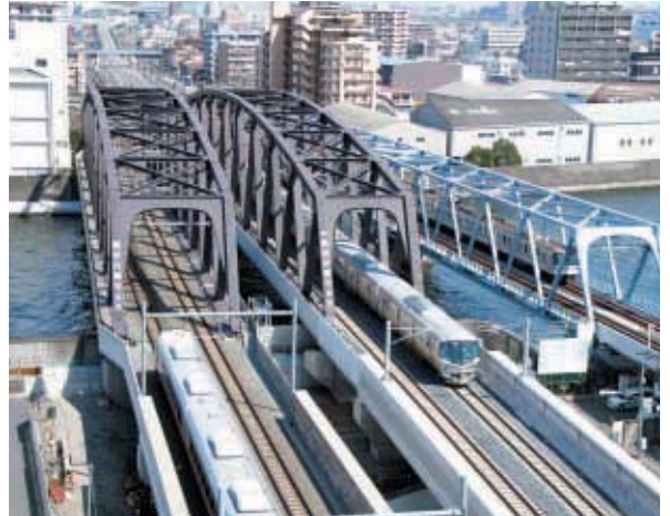
厚生労働大臣賞 常磐新線隅田川橋梁建設
