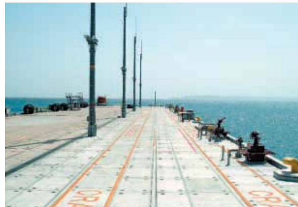
栈橋全景(完成)
