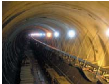
トンネル坑内 ベルトコンベアーによる土砂運搬状況
