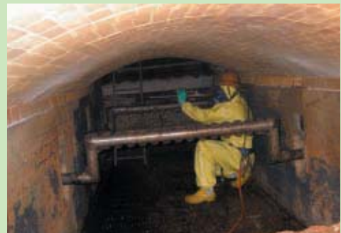
焼却設備の除染・洗浄状況
