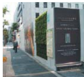
歩道仮囲いの壁面緑化 全景
