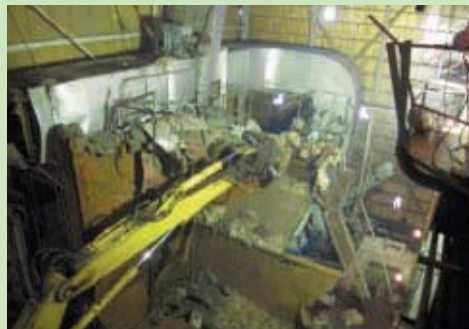
焼却設備の解体状況
