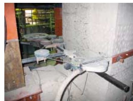
無水ワイヤーソーによる切断
