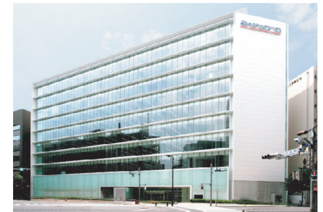
akebono日本橋ビル
