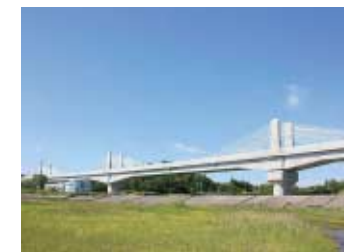
三内丸山架道橋
