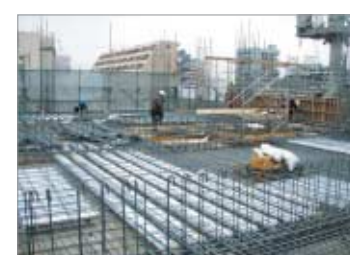
スラブ配筋状況
