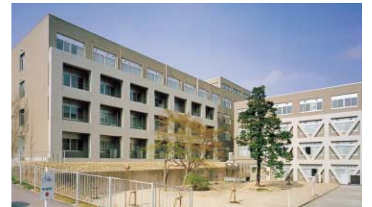
工学部3号館 南西面外観
