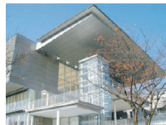
建物東側大庇
