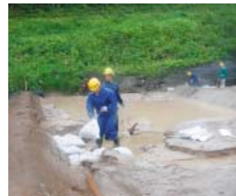
災害復旧作業状況
