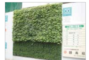
パークハウス三番町新築工事
