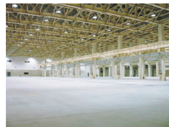
地下2階組立工場内部
