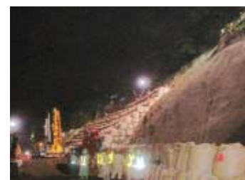
災害復旧作業状況
