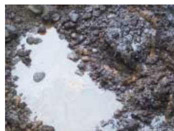
油汚染状況(油膜あり)
