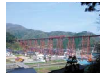
余部鉄橋(旧橋)
