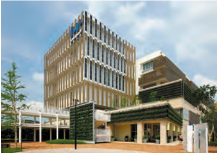
エネルギー棟
