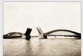
勝鬨橋 東京 1937 (昭和12) 年
