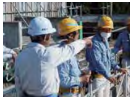
工事品質パトロール
