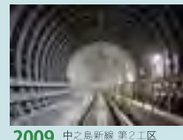
2009 中之島新線 第2工区 (大阪 平成21)
