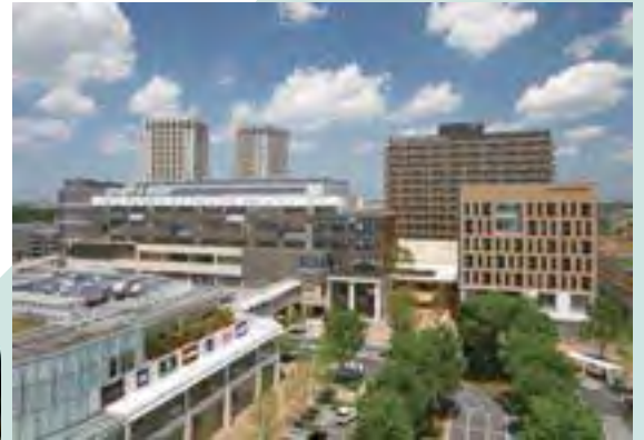
2014 日本初の平常時電力融通を可能とした 柏の葉スマートシティゲートスクエア (千葉 平成26)
