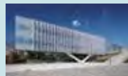
2011 三角形のガラスハウス 東京工業大学付属図書館 (東京 平成23)
