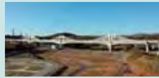
2008 エクストロードード (鉄道) 線 三内丸山築道橋 (青森 平成20)
