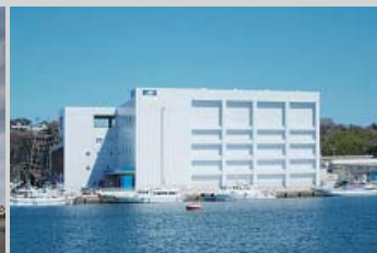
福島県漁業協同組合連合会 小名浜冷凍冷蔵施設
