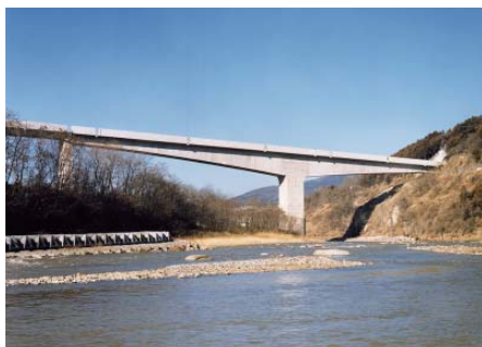
東北新幹線 吾妻川橋(1978年)
