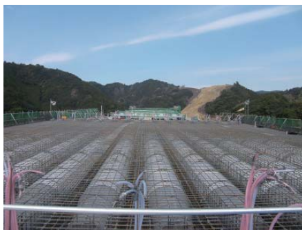
円筒型枠(中空床版)
