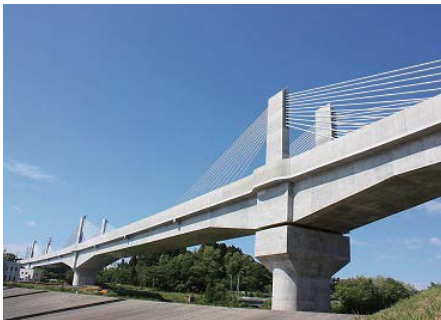
東北新幹線 三内丸山架道橋(2008年)
