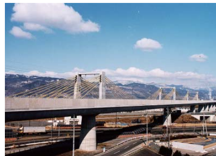
北陸新幹線 屋代橋りょう(1996年)
