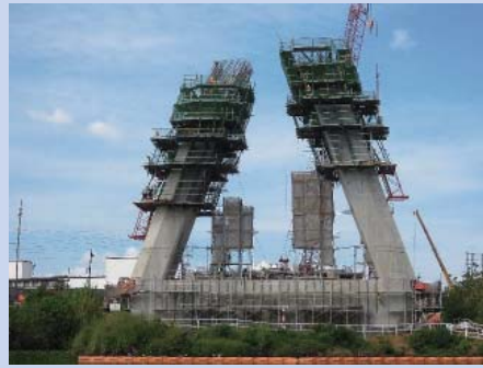
施工中の主塔
