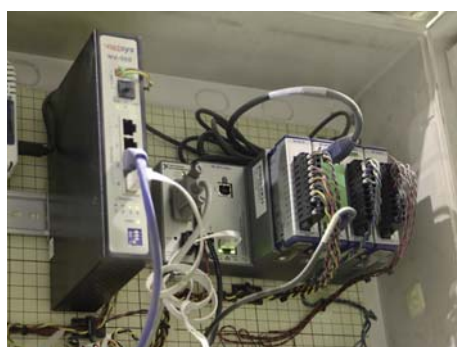
組込型制御端末の設置例
