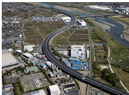
圏央道 金田高架橋(2013年)
