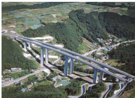
関越自動車道 永井川橋(1985年)
