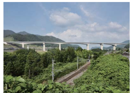
京都縦貫自動車道 由良川橋(2015年)
