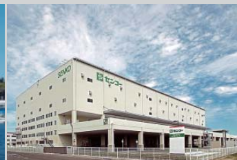
センコー 仙台港PDセンター
