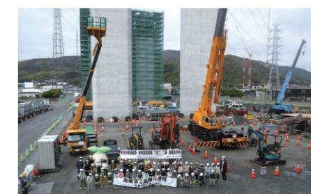
新名神高速道路 高槻高架橋東(下部工) 工事作業所(大阪府)
