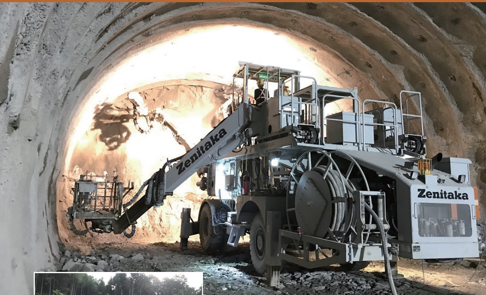
削孔作業 「ドリルジャンボ」という重機によりダイナマイトを入れる穴を掘る
