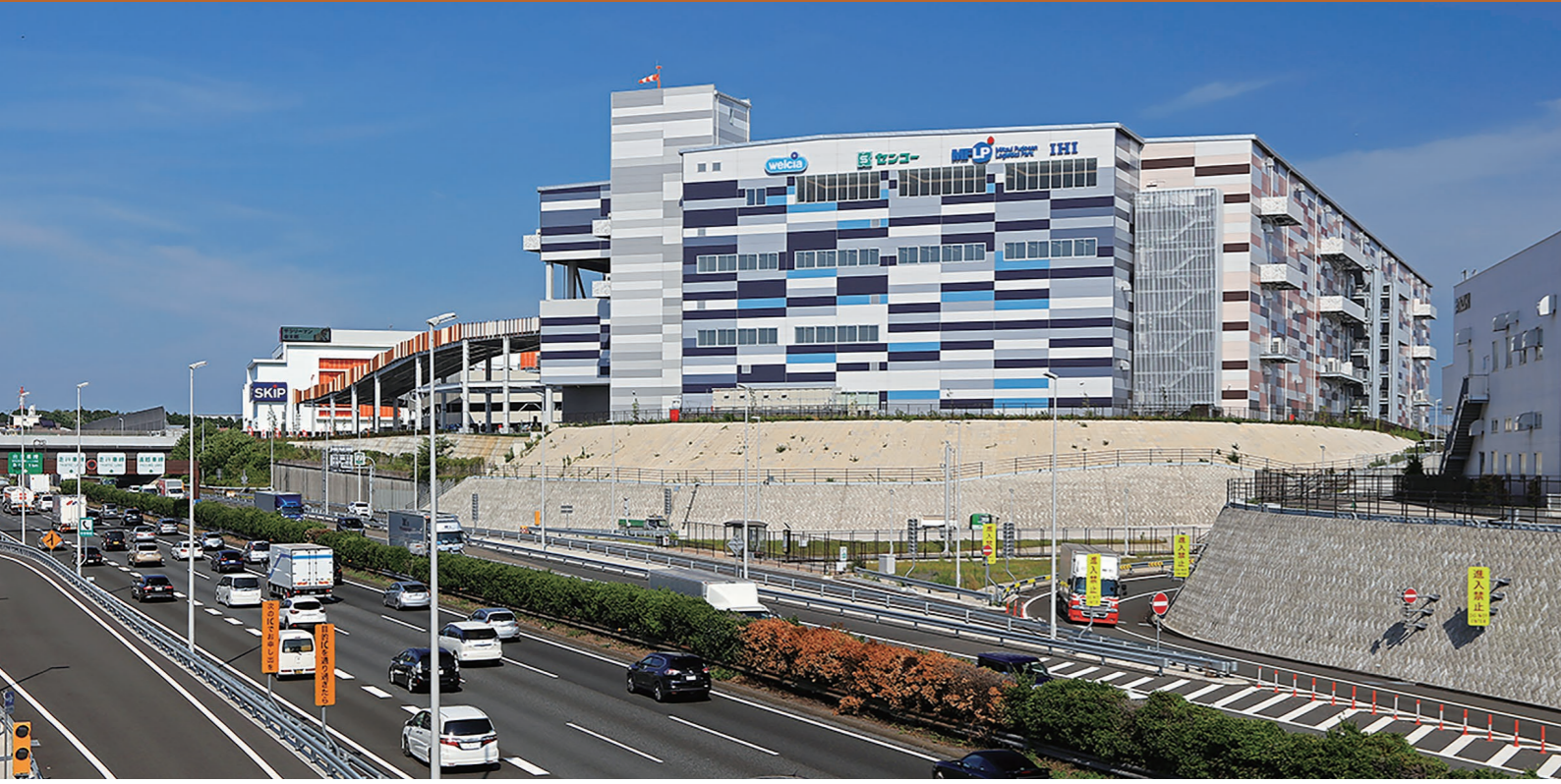
施設全景 手前は東名高速道路
