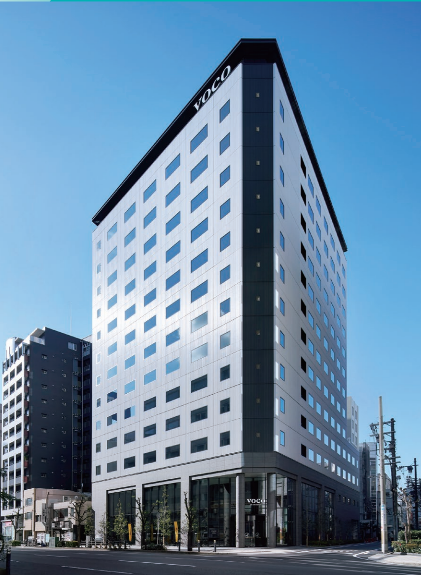
①外観 四つ橋筋に面するシンメトリー性の高い立面
