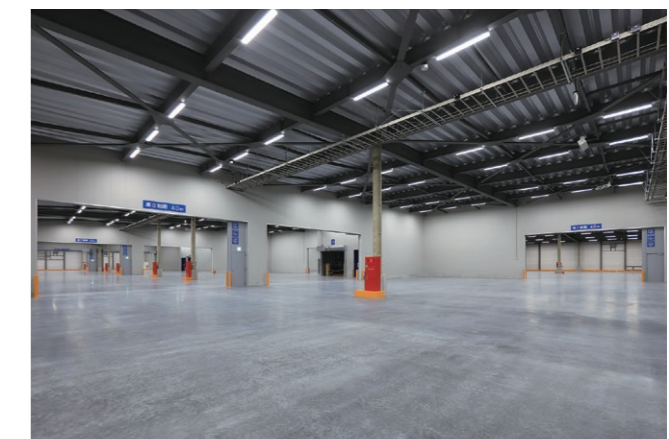
ひび割れ防止対策を施した床コンクリートの施工事例 (三菱地所 ロジクロス座間小松原) 日本で初めて英国コンクリート協会の定める床仕様の実用的な最高水準「FM2クラス」を達成。
