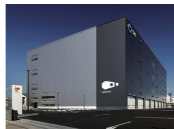
シーアールイー ロジスクエア厚木I 2023年3月竣工 ZEB認証取得 エネルギー消費削減率 100%*
