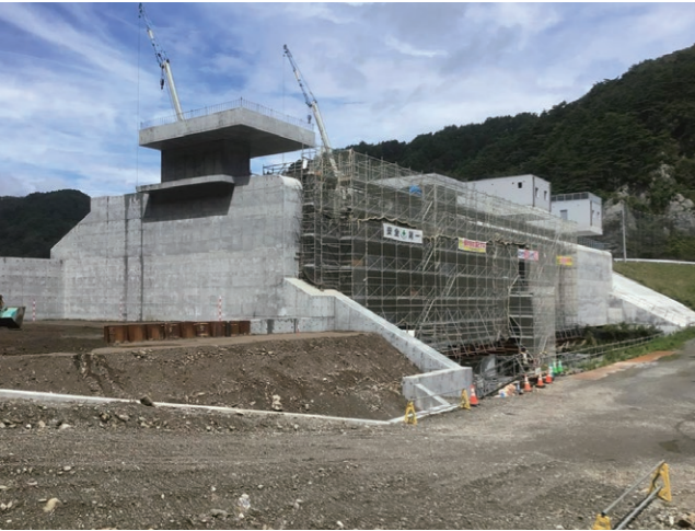
水門部分(施工中)
