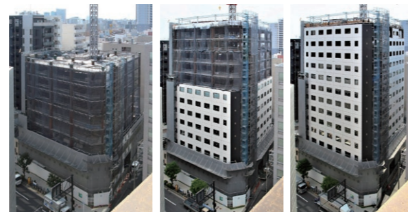
⑫工事の進行の様子 建物の内側から外壁を取り付ける、安全性の高い「無足場工法」を採用
