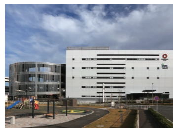
大和ハウス工業 DPL新横浜II 2022年11月竣工 ZEB Ready認証取得 エネルギー消費削減率 53%*
