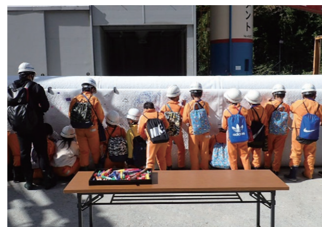
地域の小学生を対象とした現場見学会 トンネル内に設置する防水シートに将来の夢やメッセージ等を思い思いに書いていただきました。(福島県いわき市 国道6号 勿来トンネル工事作業所)
