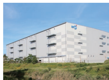
三井不動産 ロジスティクスパーク川口I 2019年10月竣工 ZEB Ready認証取得 エネルギー消費削減率 53%*
