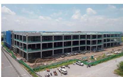
2022年8月 PC建方工事完了
