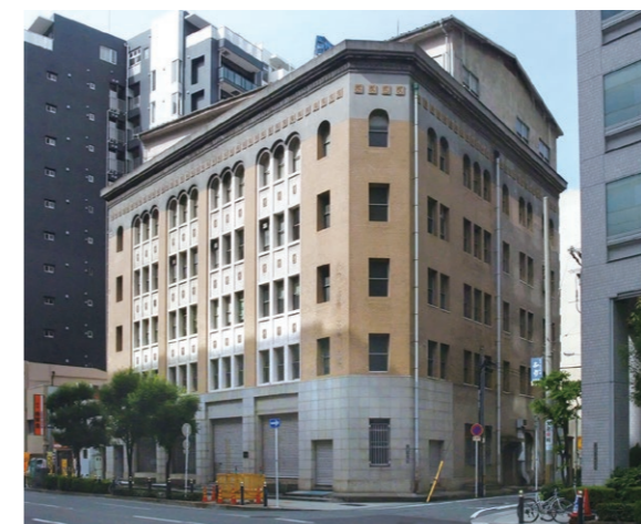
⑧京町ビル(2011年撮影) 1960(昭和35)年まで銭高組の本社だった
