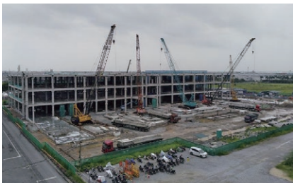
2022年6月 PC建方工事(5スパン目)
