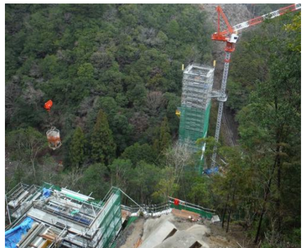
写真-9 ケーブルクレーンによるコンクリート運搬
