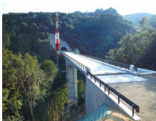
写真-10 橋梁全景 A1 から A2 を望む
