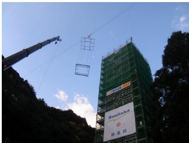
写真-5 ケーブルクレーンを使用した橋脚部鉄筋組立
