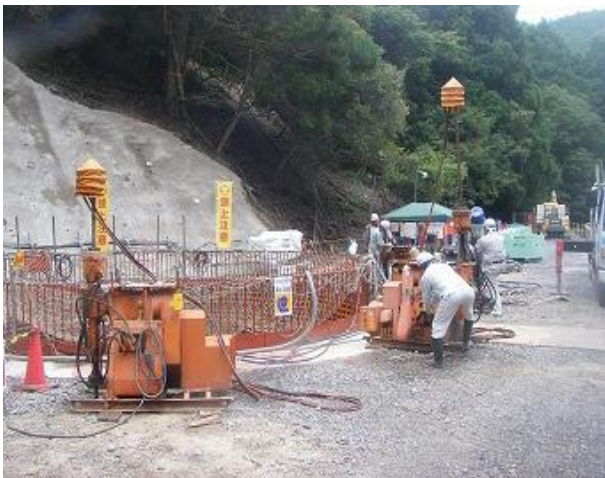
写真-4 薬液注入工実施状況
