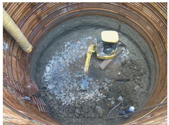
写真-2 大口径深礎杭の施工状況
