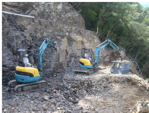
写真-7 橋台背面掘削、掘削土積み込み状況
