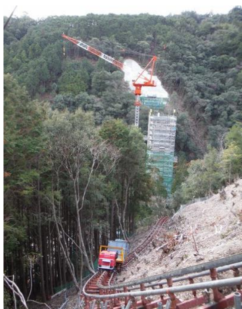
写真-8 大型モノレールによる土砂運搬状況
