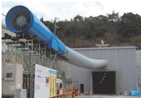
写真-1 志度トンネル坑口
