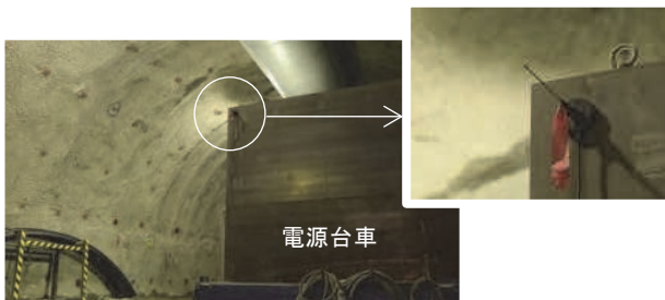
写真-5 リーダーの設置(切羽付近の検知用)
