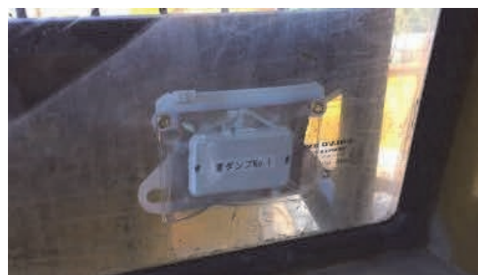
写真-6 ダンプトラックのRFIDタグ設置
