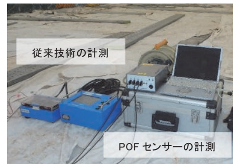
写真-11 充填検知計測状況
