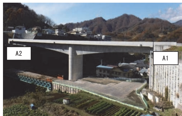
写真-1 大月バイパス 桂川橋遠景
