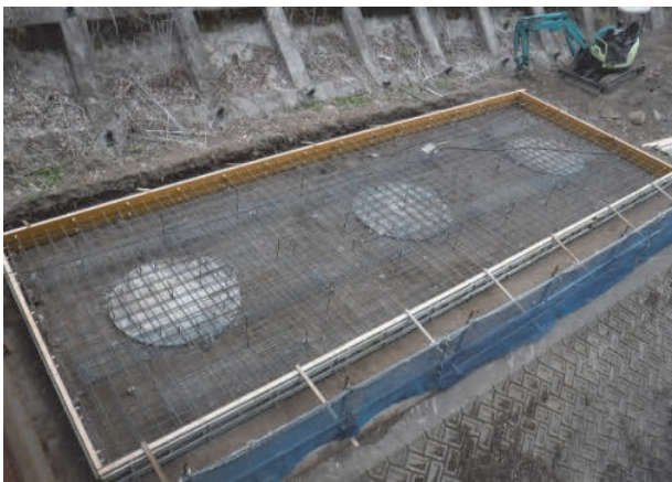
写真-2 仮設深礎施工状況
