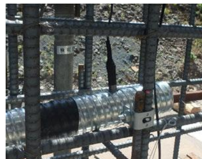
写真-8 センサーの設置状況
