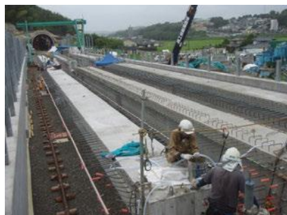
写真-9 PCグラウト注入作業状況
