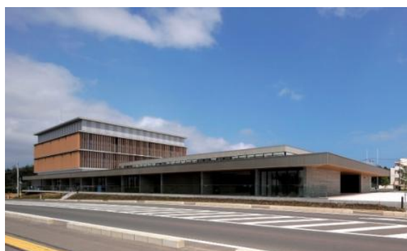
写真-1 本庁舎南西面全景
