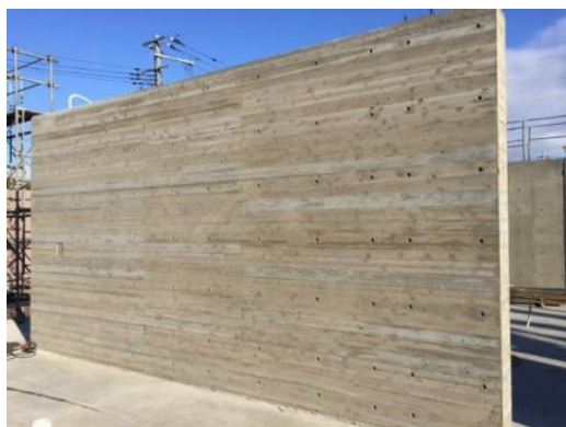
写真-7 コンクリート打上り状況
