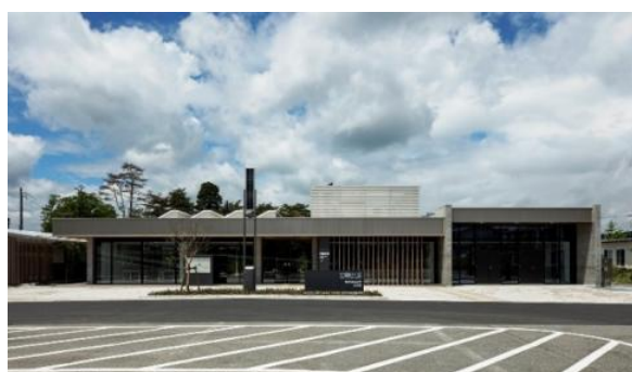
写真-2 歌津総合支所東面全景
