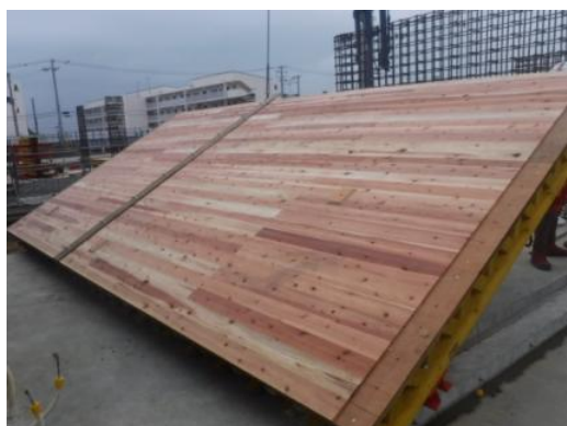
写真-6 杉板を張った型枠表面
