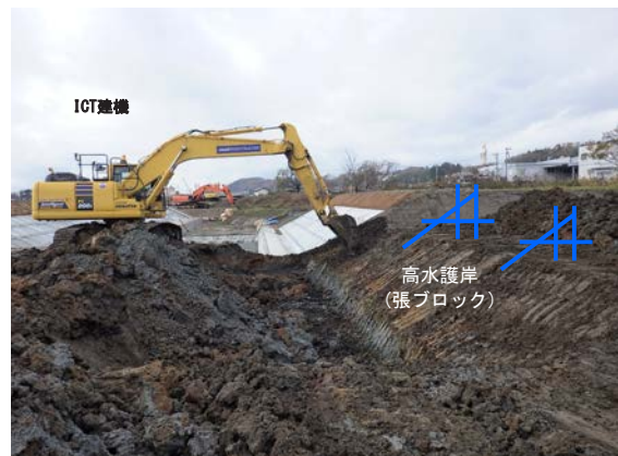
写真-4 施工状況②
