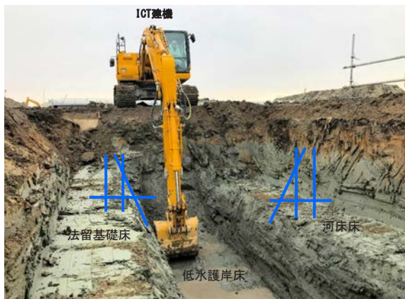
写真-6 施工状況④
