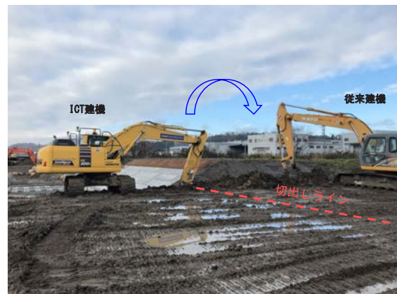
写真-3 施工状況①
