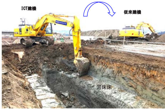
写真-5 施工状況③
