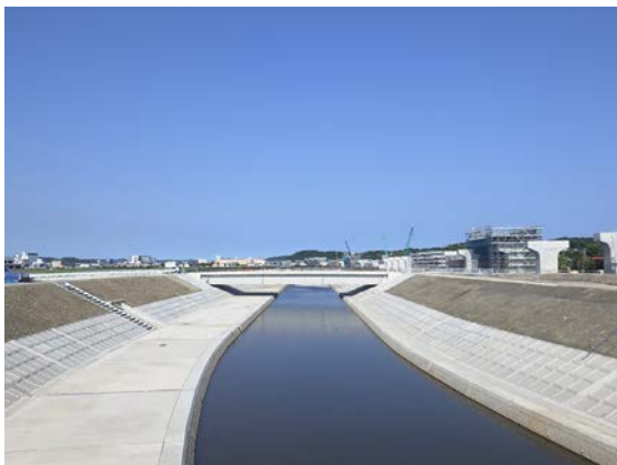
写真-8 河川全景（下流側）
