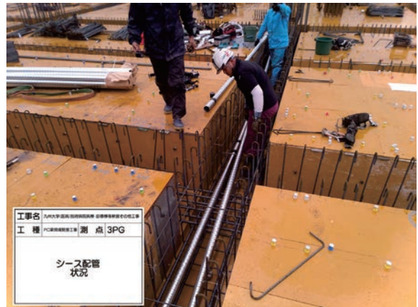
写真-2 シース管配管状況
