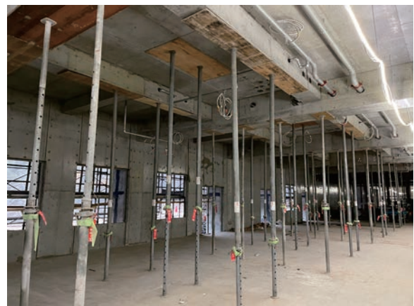
写真-6 残存サポート設置状況
