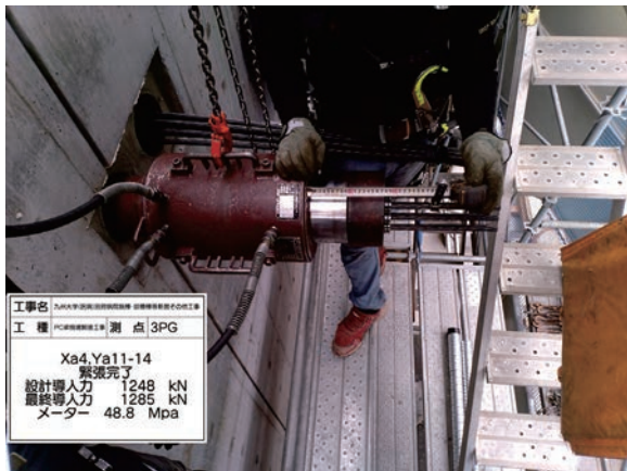
写真-4 PC 緊張施工状況
